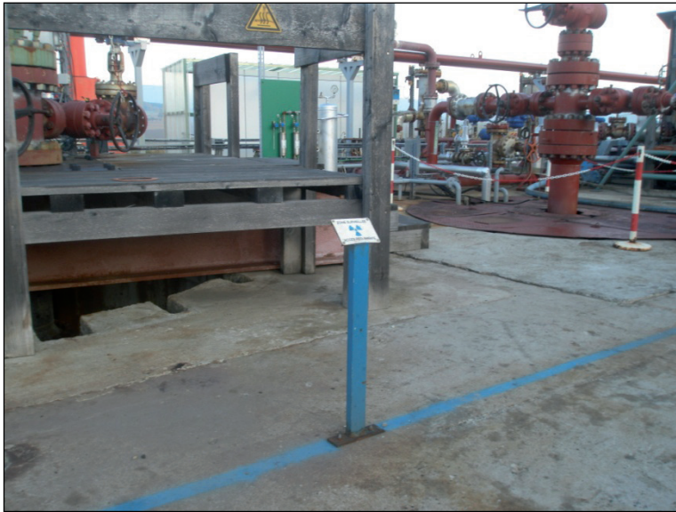
Abb. 71: Zoneneinteilung auf der Kraftwerksanlage.
