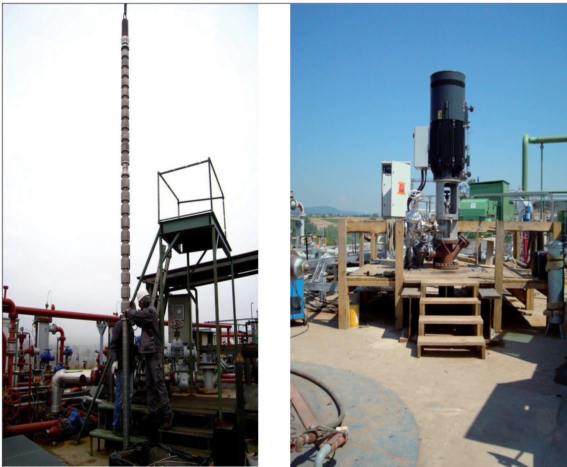
Abb. 42: Pumpenkörper mit den Pumpenstufen und Filter vor dem Einbau (links) und obertägiger Antriebsmotor (rechts).
