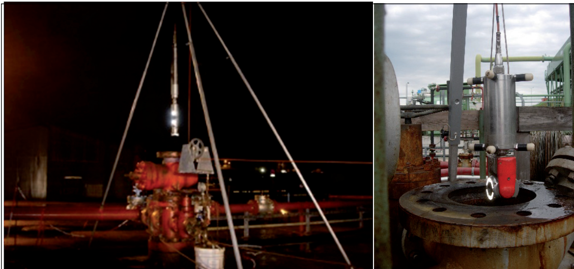
Abb. 37: Kamerabefahrung der Bohrungen GPK1 durch das LIAG (links) und der Bohrung GPK2 durch die Firma Osel-Bohr (rechts).
